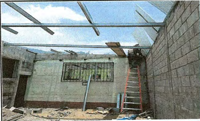
Foto 1: Remozamiento General de aula en proceso
